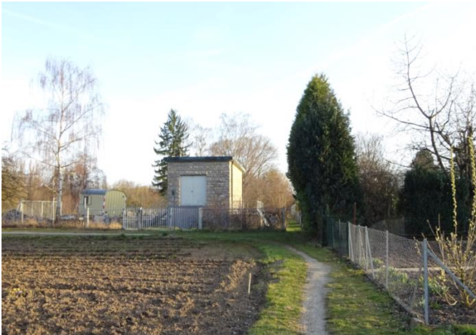
Abbildung 14: Foto RÜB5 / Pumpstation
