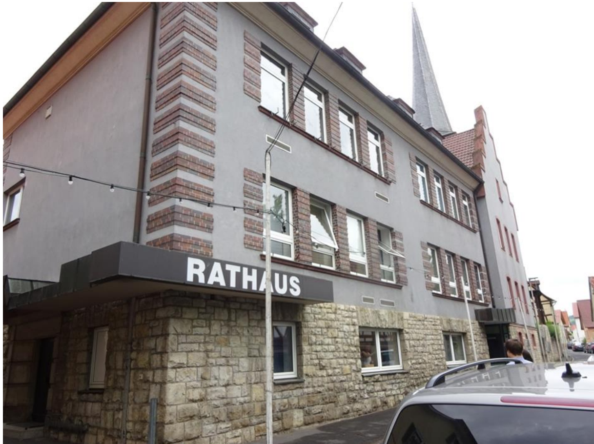
Abbildung 4: Das Rathaus Margetshöchheim
