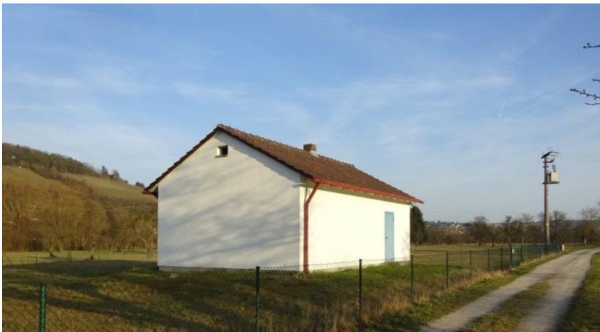
Abbildung 12: Foto Wasserwerk Margetshöchheim
